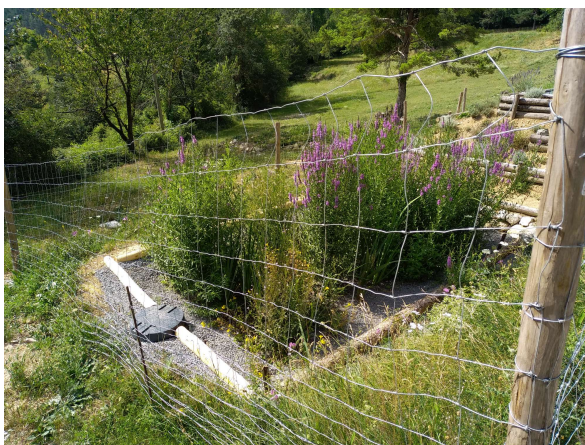
Photo prise lors d'un contrôle de bon fonctionnement d'un filtre planté
