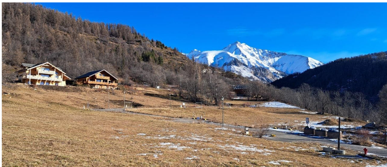
Figure 8 : coffrets de raccordement, éclairage public et conteneurs OM installés
