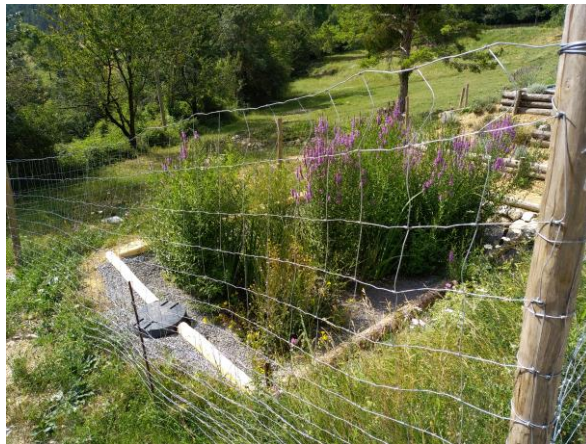
Photo prise lors d'un contrôle de bon fonctionnement d'un filtre planté
