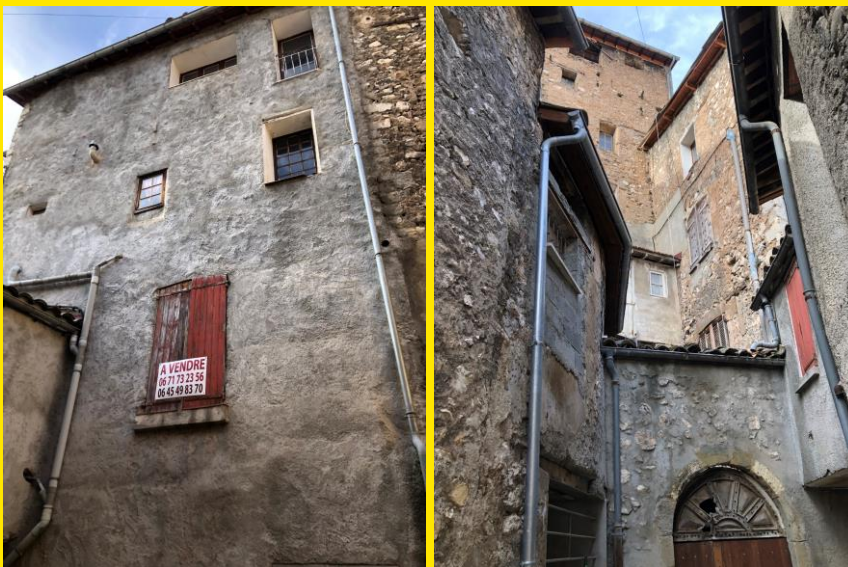
Depuis l'arrière de l'immeuble
