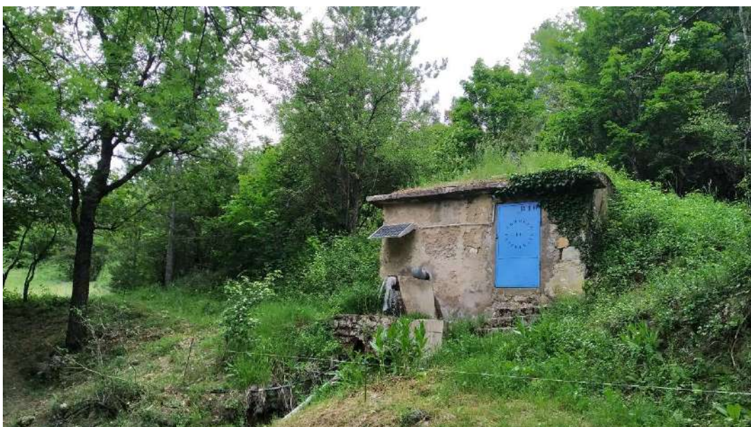
Photo 2 : Captage de Basse Lagne
