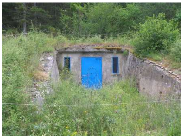
Captage de La Lagne
