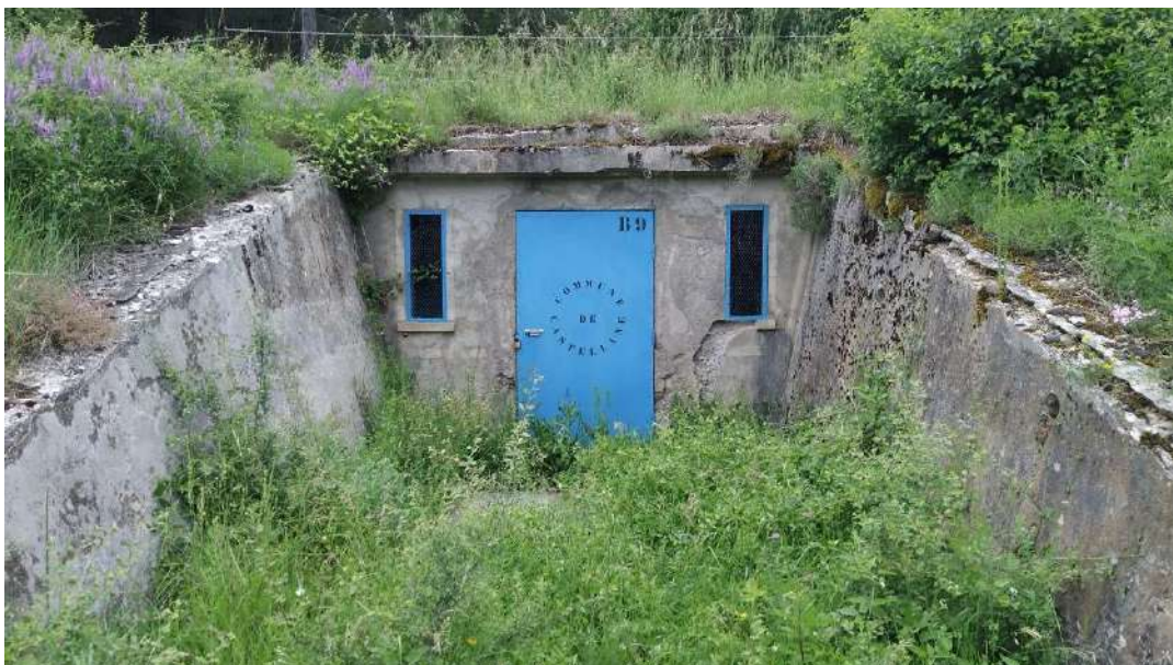
Photo 1 : Captage de Lagne
