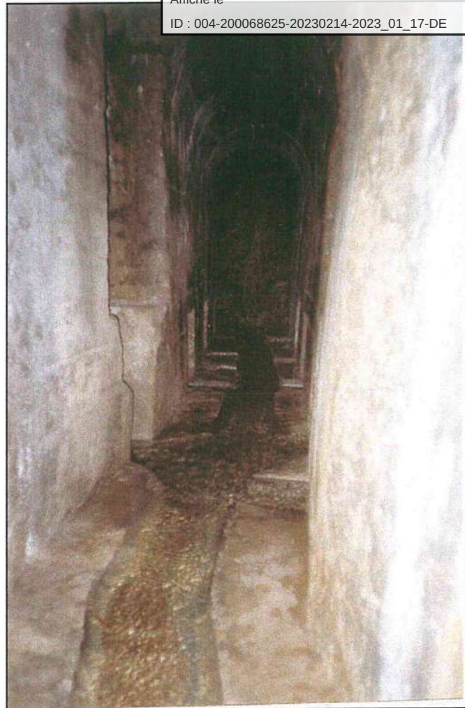
Vue n°4 Vue vers le couloir de direction N 27°
