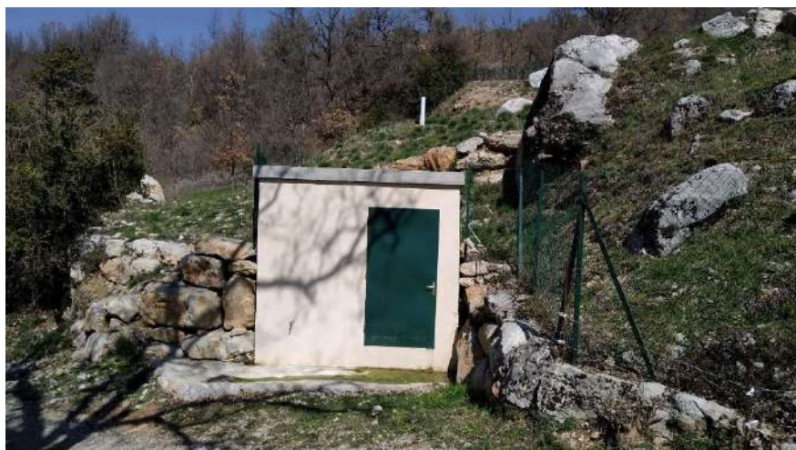
Photo 1 : Captage des Ferrayes
