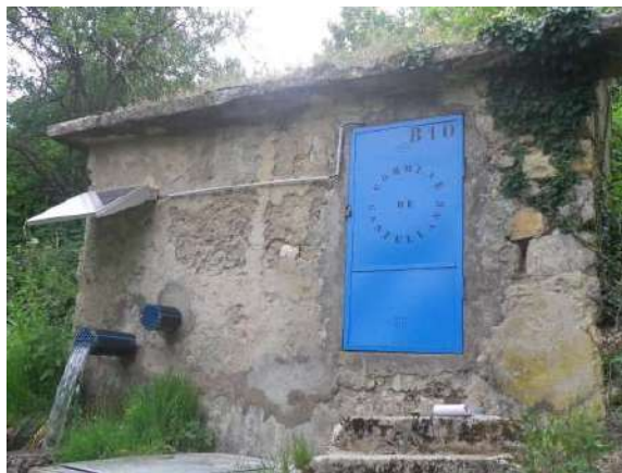
Captage de Basse Lagne
