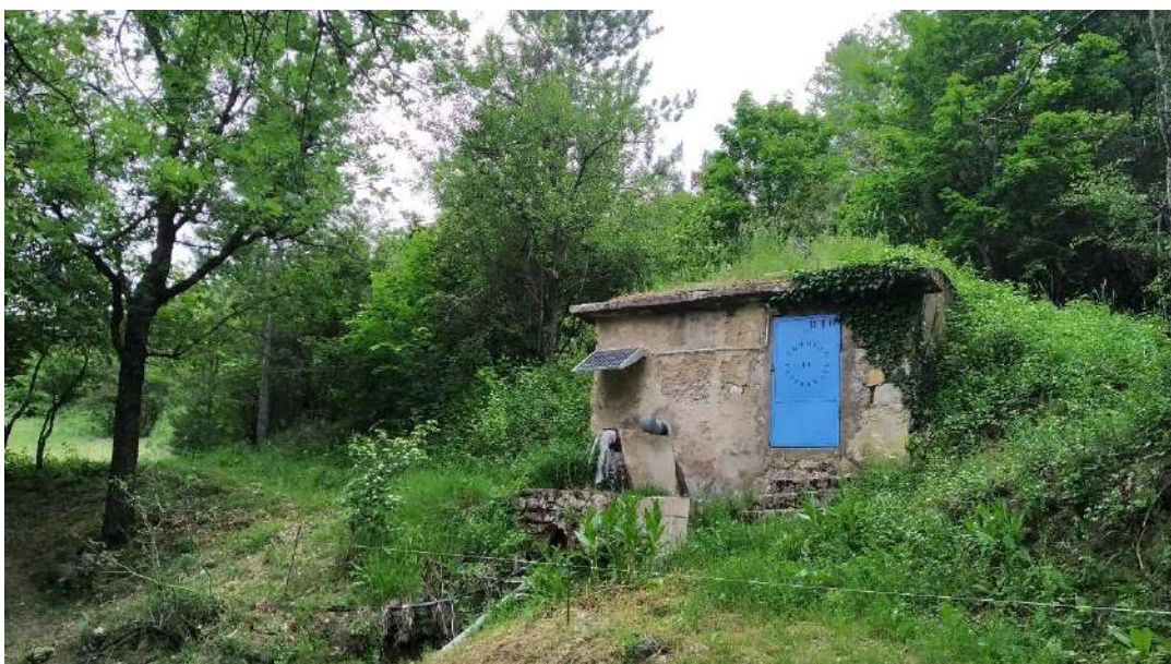
Photo 2 : Captage de Basse Lagne
