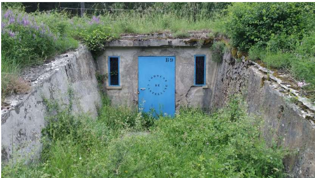
Photo 1 : Captage de Lagne
