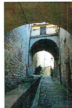
TRACES DES REMPARTS RUE DES MOULINS
