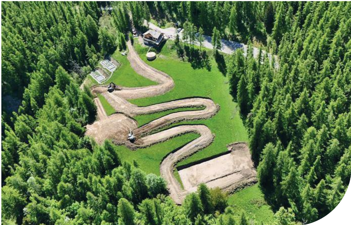
Temporairement interrompus cet été pour préserver la tranquillité de la faune locale, les travaux reprennent dès ce mois-ci à Ratéry Photo © ECOXYGENE
