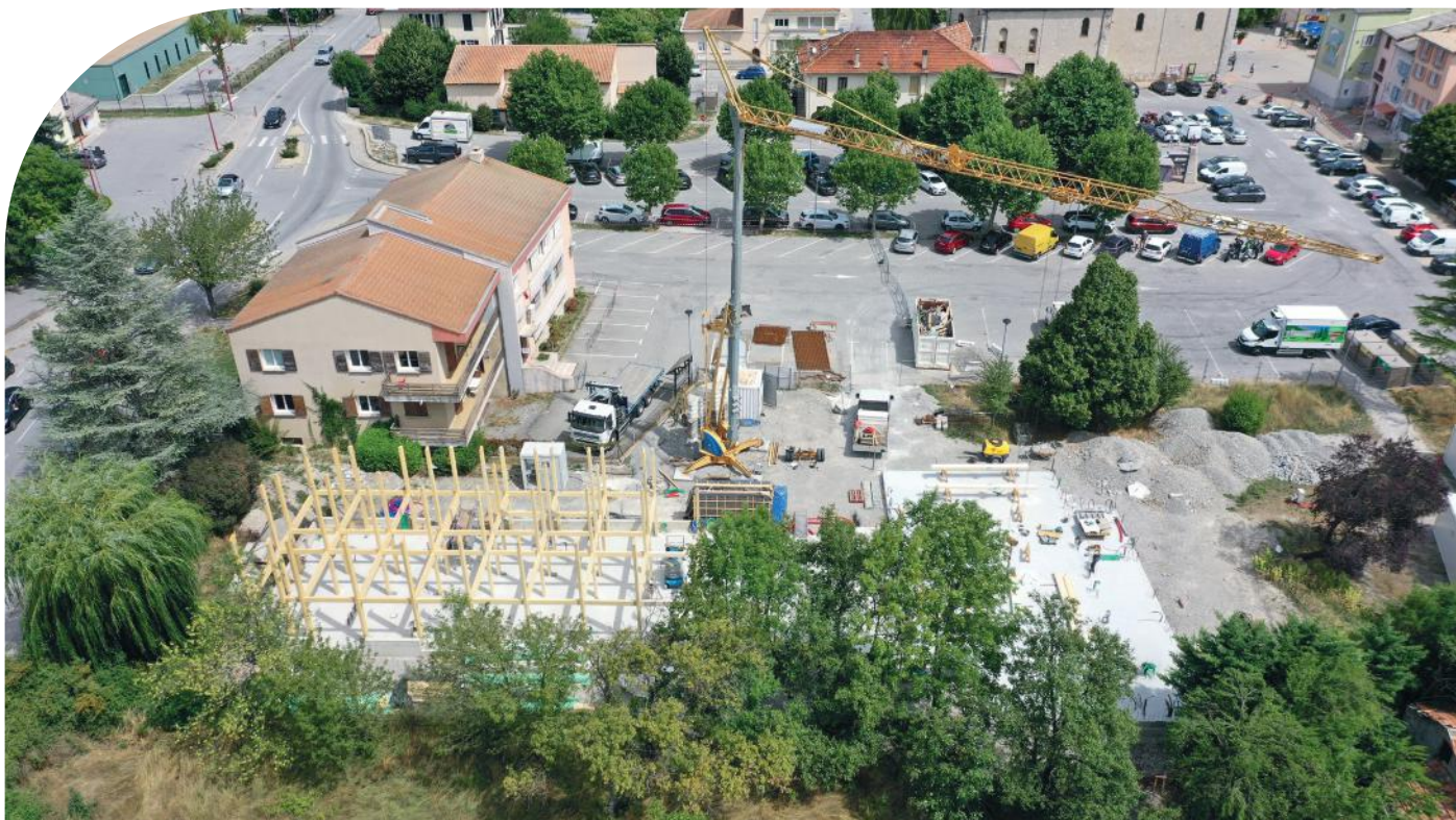
Une étape majeure est franchie dans la construction du futur siège de la CCAPV à Saint-André-les-Alpes.
